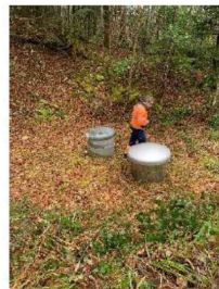
Figure 3 : Captages des sources de Noire Fontaine
