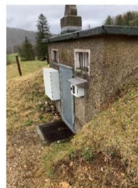
Figure 7 : Réservoir du Bambois
